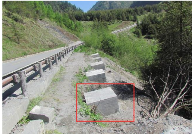
Stabilisierungspfähle (ganze unter dem Geländeniveau)
